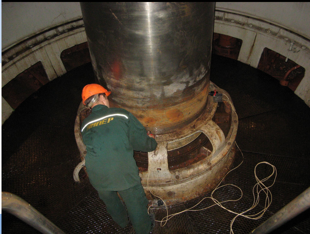
Установка датчиков биения вала в районе турбинного подшипника
